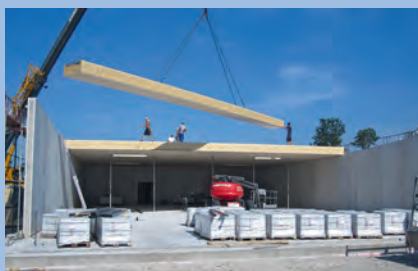
Mit einer Spannweite von 18 Meter und einer Bauhöhe von 48,5 cm eignen sich die Elemente besonders für weitgespannte Tragwerke
